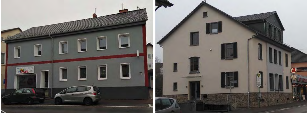
Abbildung 43: Modernisierung der historischen Bausubstanz in der Kaiserstraße
