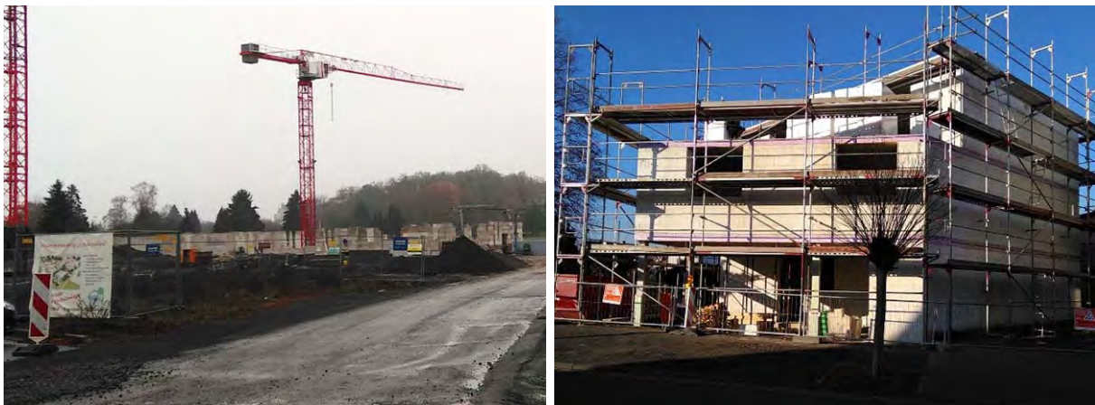
Abbildung 44: In Bau befindliches Seniorenheim in der Lindenallee (links) und Neubau in der Robert-Koch-Straße (rechts)
