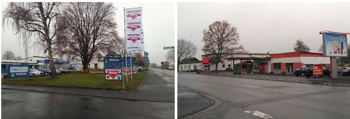
Abbildung 29: Gewerbeflächen am westlichen Ortseingang der Kernstadt Hungens
