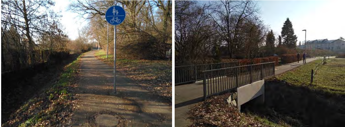
Abbildung 54: Fuß- und Radweg entlang des Froschgrabens (links) und in Richtung Bahnhof (rechts) nördlich der Bahntrasse
