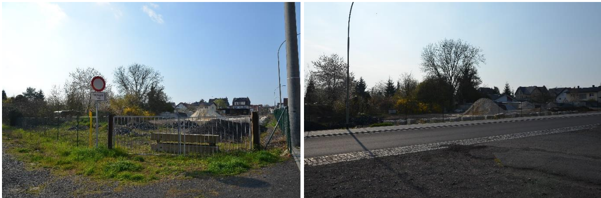
Kieslager Julius-Fendt Straße
