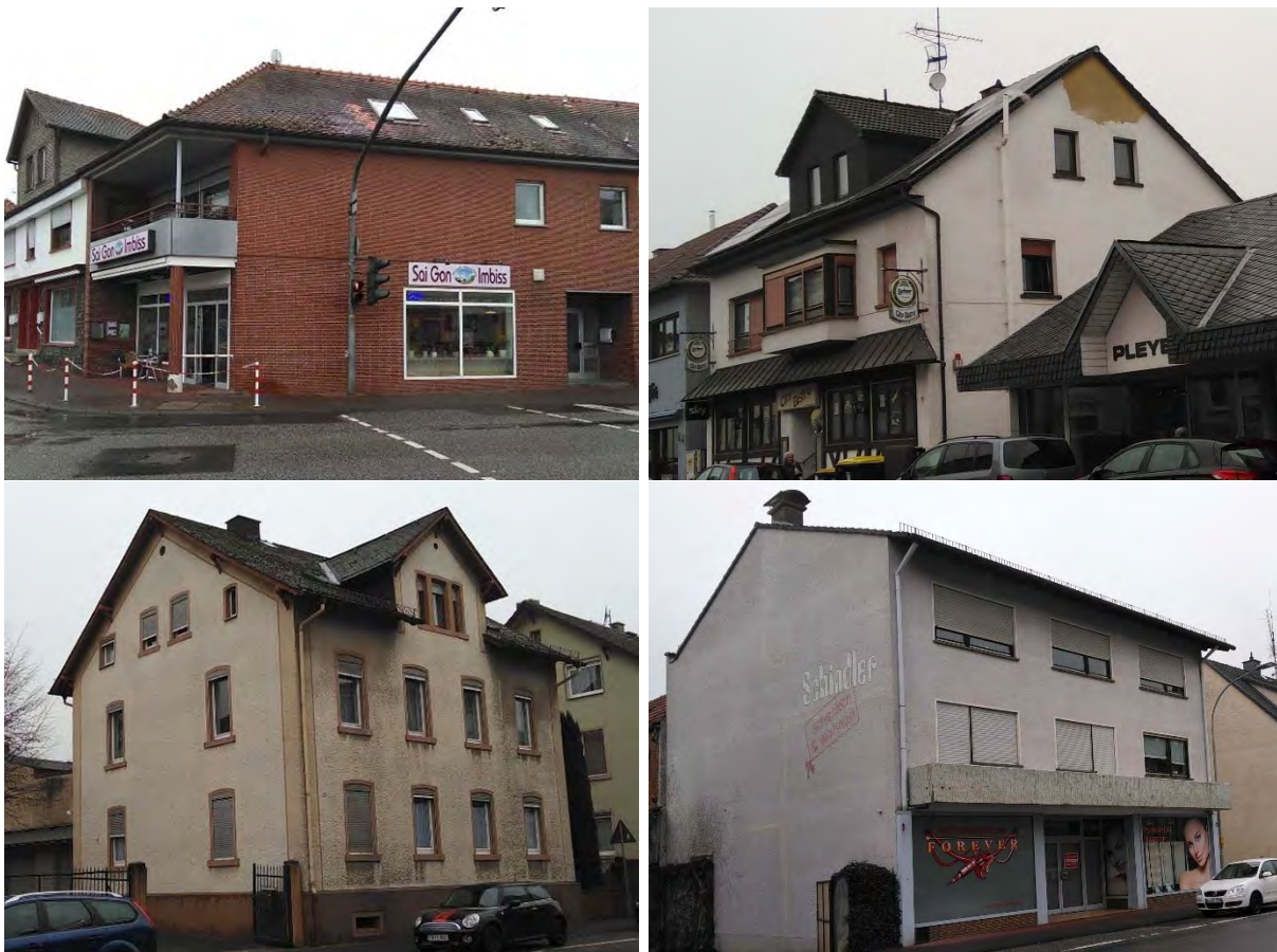
Abbildung 41: Modernisierungsbedarf an Gebäuden in der Kaiserstraße und Gießener Straße
