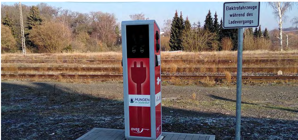
Abbildung 56: Ladestation für Elektrofahrzeuge am Bahnhof Hungen
