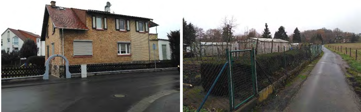
Abbildung 32: Wohnbebauung (links) und Kleingärten (rechts) nördlich der Bahnlinie
