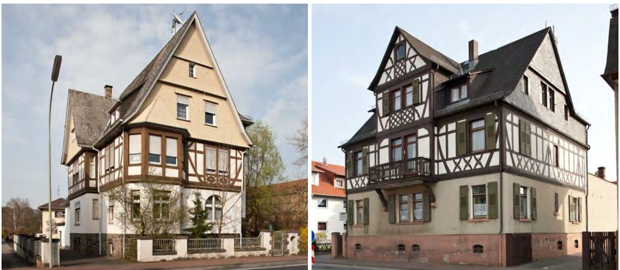
Abbildung 38: Einzelkulturdenkmal Gießener Straße 5 (links) und Gießener Straße 14 (rechts) Quelle: Landesamt für Denkmalpflege Hessen, http://denkxweb.denkmalpflege-hessen.de/objekte/
