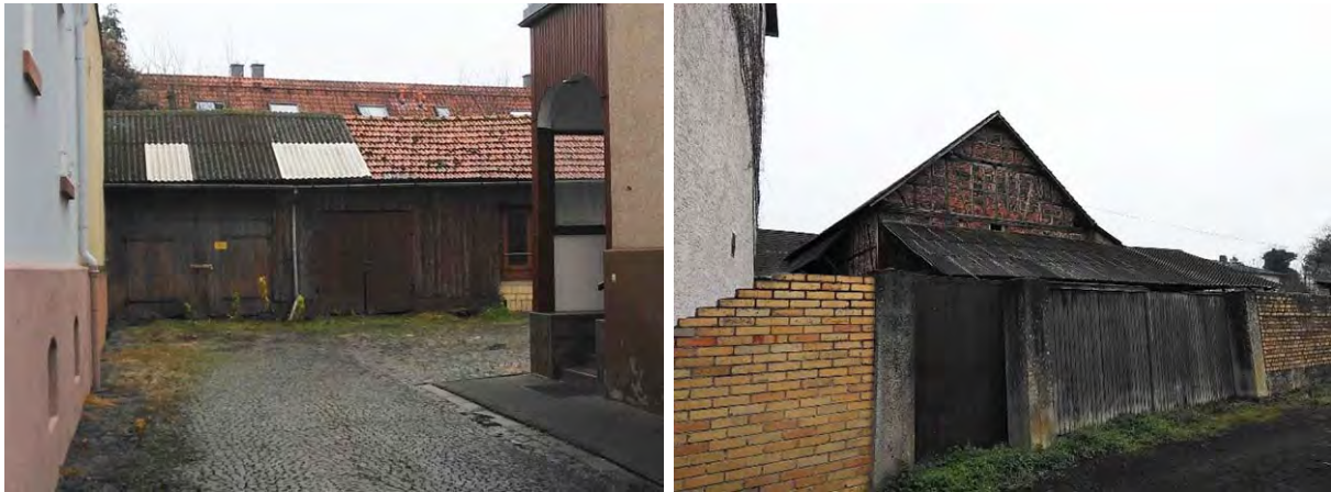
Abbildung 47: Untergenutzte Nebengebäude im Untersuchungsgebiet
