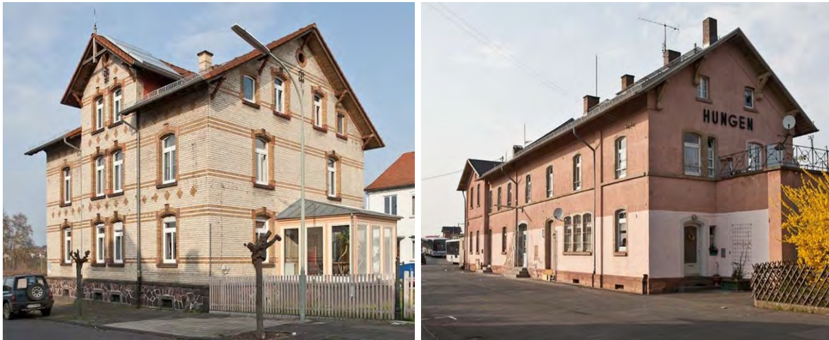
Abbildung 39: Einzelkulturdenkmal Raiffeisenstraße 5 (links) und Raiffeisenstraße 7 / Bahnhof Hungen (rechts) Quelle: Landesamt für Denkmalpflege Hessen, http://denkxweb.denkmalpflege-hessen.de/objekte/
