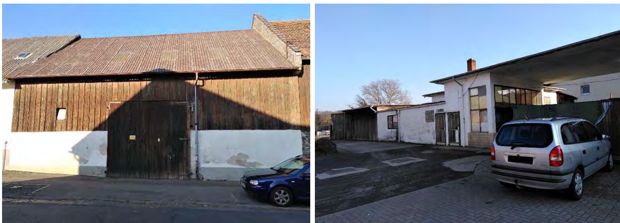
Abbildung 42: Gravierende Baumängel an Gebäuden an der Robert-Koch-Straße und Gießener Straße
